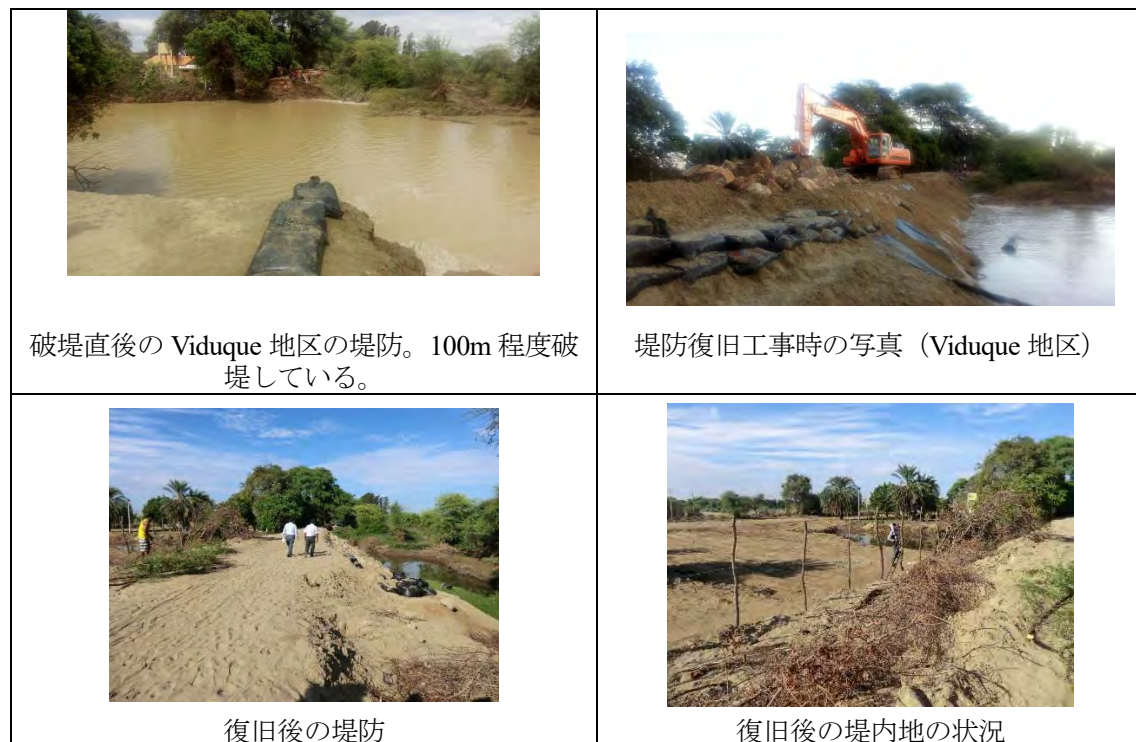
図 13.2.9 河川流下能力を超える洪水が発生した Piura 川の破堤部及び補修状況
