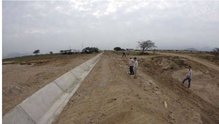
写真 溪流横断部に復旧した水路工。溪流を完全に遮断している。
