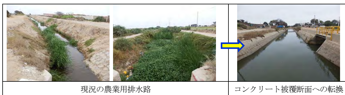
図 13.3.65 現況の農業排水路のコンクリート被覆断面への転換
