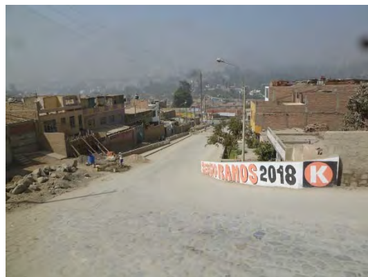
下流側は道路が流路になっている。民家はパラペットでかろうじて守られている。
