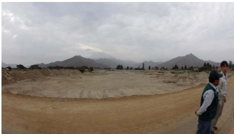
写真 道路横断部から上流方向を撮影。溪岸が侵食されているとのこと。溪床と道路の比高差が小さい。
