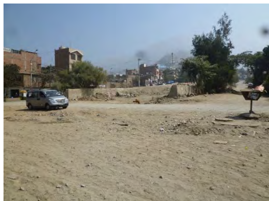
溪流と道路の交差部。溪床との比高が確保できないため護岸はパラペット形式。
