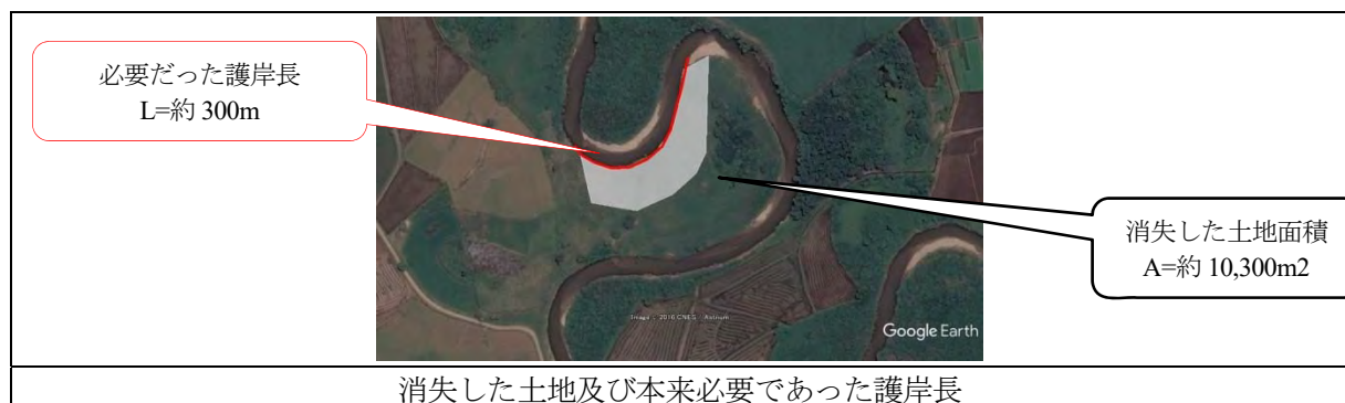
図 10.3.2 Huallaga 川流域 Rio Cisa の洗掘状況-2
