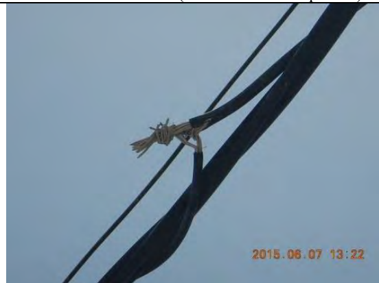
Temporary repaired cable (Beit Hanoun)
