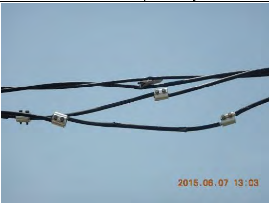
Temporary repaired cable (Beit Hanoun)
