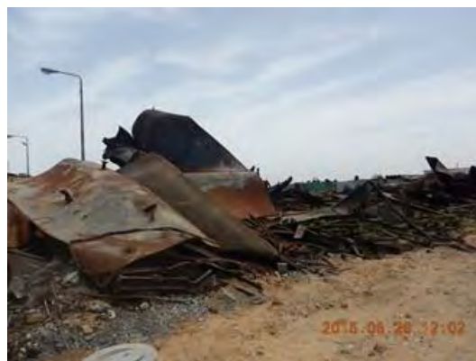
図 1-10 破壊された燃料タンクの様子
