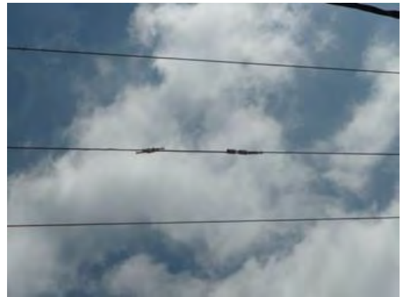
図 1-15 応急処置された 22kV 配電線
