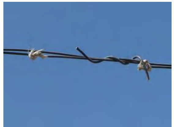
図 1-16 応急処置された 0.4kV 配電線
