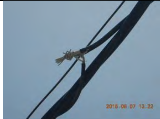
応急修理された電線 (Beit Hanoun 市)
