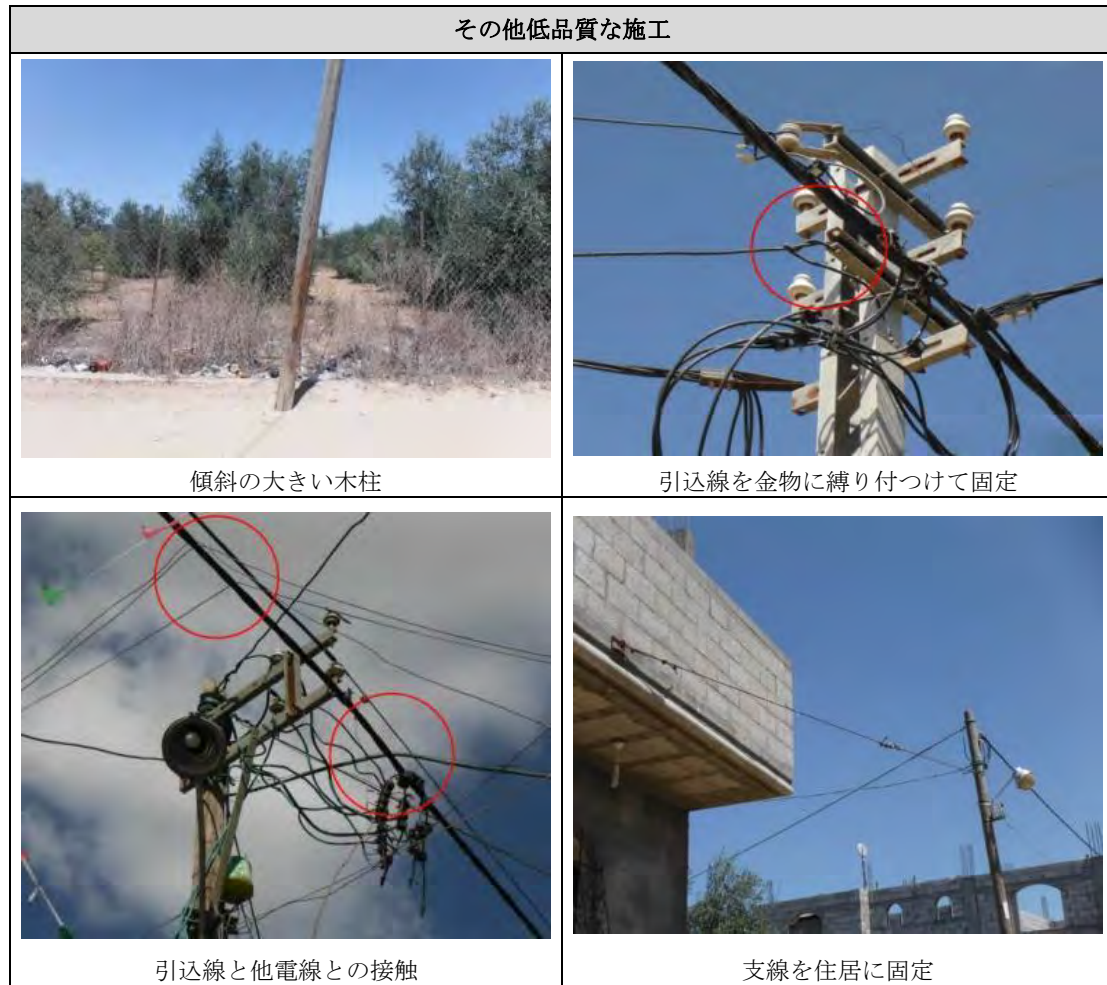
図 2-10 低品質な施工と指摘による是正
