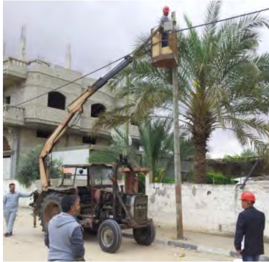
図 2-9 高所作業車による危険な高所作業（安全帯とアウトリガー不使用）
