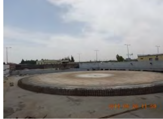
ガザ発電所の燃料タンクの基礎（建設停止）
