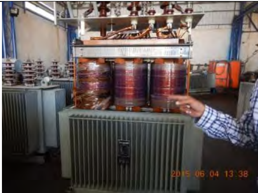
変圧器修理工場
