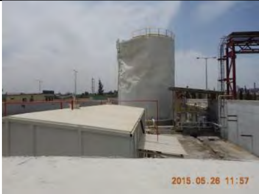
ガザ発電所の仮設燃料タンク（下の建屋）
