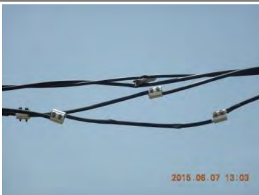
応急修理された電線 (Beit Hanoun 市)
