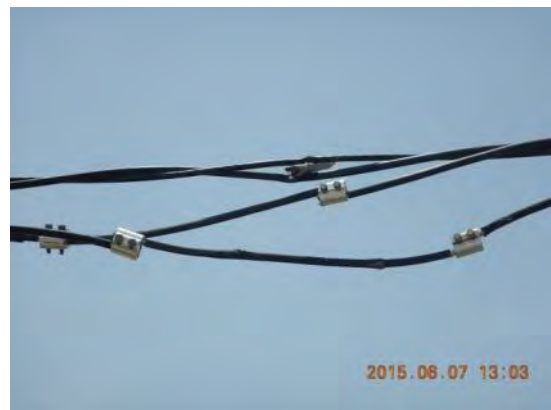
図 1-17 PG クランプでの応急処置
