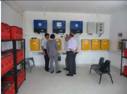
Shifa 病院の太陽光パネル制御室
