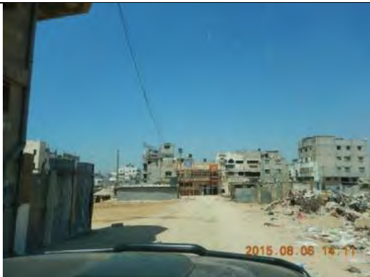
応急修理された電線 (Alshejaia 地区)
