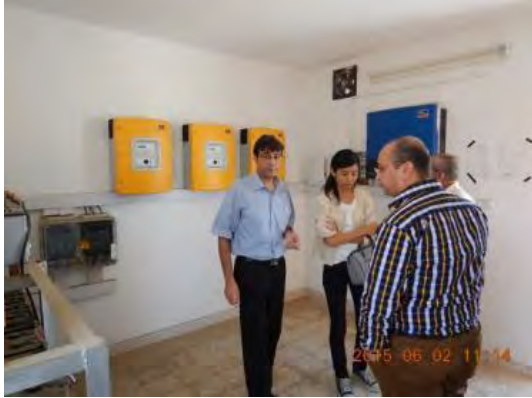
Al Faloja 学校太陽光パネル制御室
