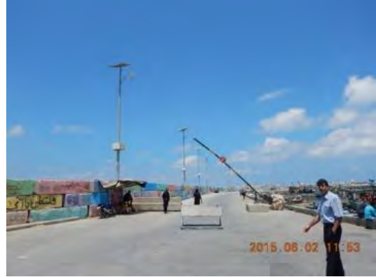
ガザ港の太陽光パネル街路灯
