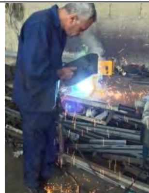
変圧器等を修理する鉄工場
