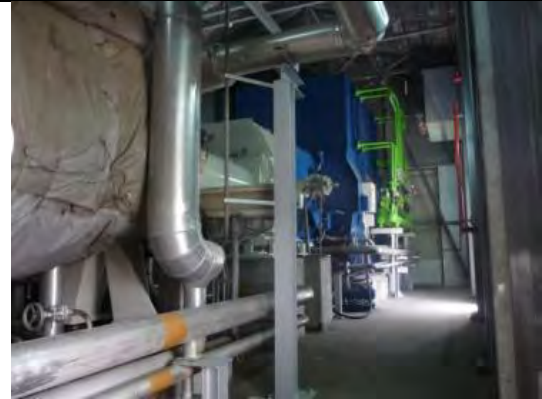
修復されたガザ発電所の発電機
