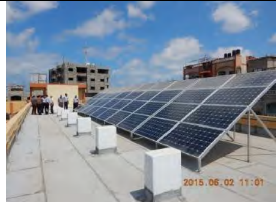
Al Faloja School 太陽光パネル
