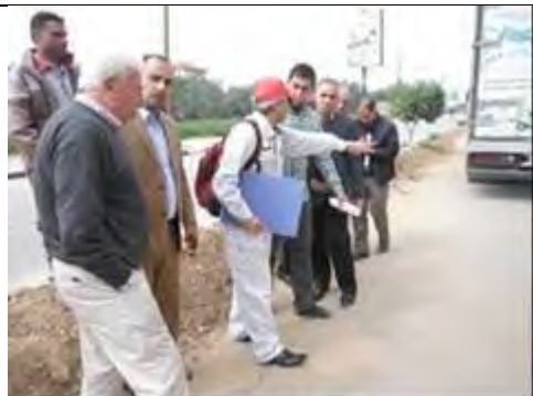
パイロットプロジェクト現地施工監理 (アブサン・アル・カベラ、2017年3月7日撮影)
