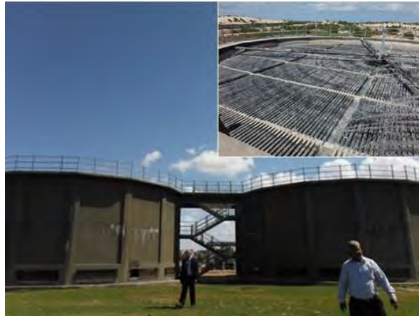
写真 6-1 Rafah WWTP に設置された散水ろ床設備とその上部
