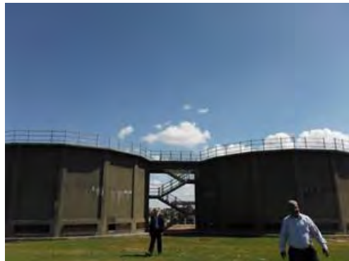
Rafah WWTP 散水ろ床設備
