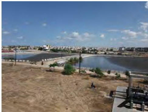
Rafah WWTP 嫌気ラグーン
