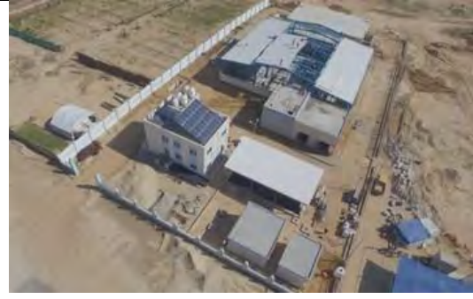
Khan Younis 海水淡水化施設 (施設規模 6,000m 3 /日) UNICEF 提供写真
