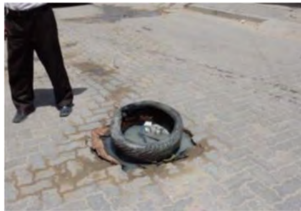
写真 6-5 公道下に設置された Pit Latrine のマンホール
