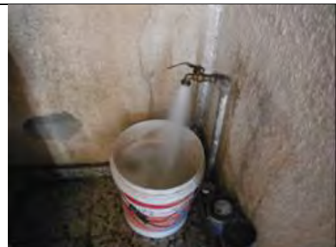
パイロットプロジェクト実施による給水状況改 善の確認(ラファハ、2017年3月8日撮影)
