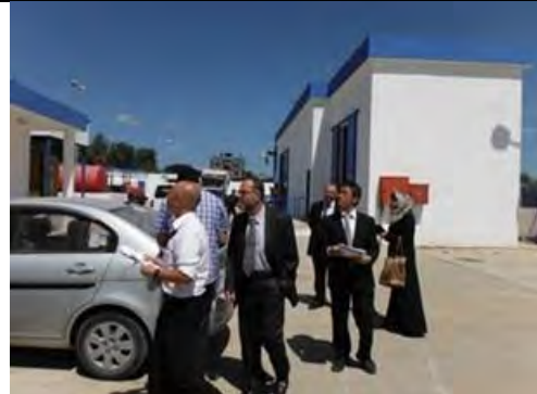
ICRC 支援による下水ポンプ場 (施設規模 14,000m 3 /日)
