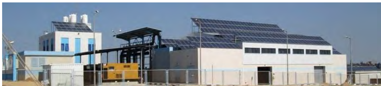
写真 6-4 ハン・ユニス海水淡水化施設屋根上部に設置された太陽光発電施設
