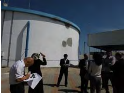
IsDB 支援による配水タンク(容量 3,000m 3 )
