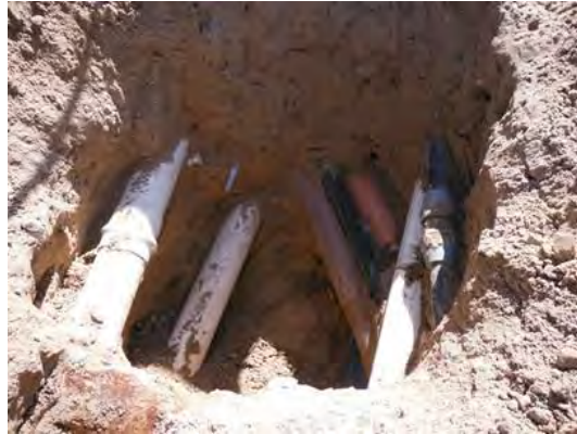
写真 2-2 無届で布設された無数の灌漑用配管(ラファハ市)
