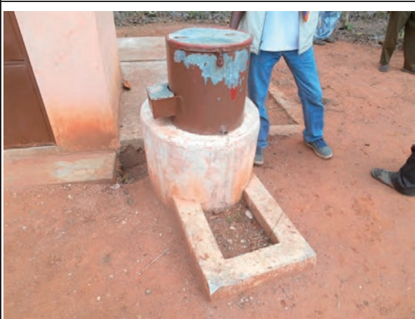
トイレの前に設置された手洗い用水タンク ID 35 EPP WINYIKPA-CENTRE
