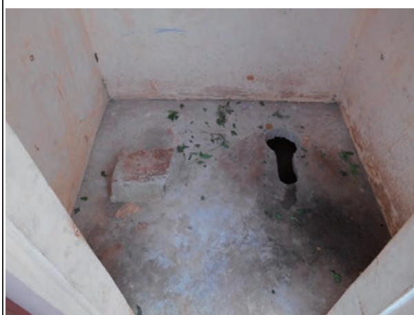
一般的なトイレの内部（2つ穴が開いており、1 つが一杯になると隣を使う） ID 35 EPP WINYIKPA-CENTRE
