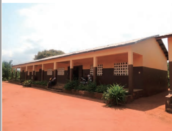
鉄筋コンクリートの既存校舎 ID 12 EPP SAVI-LOKOSSA
