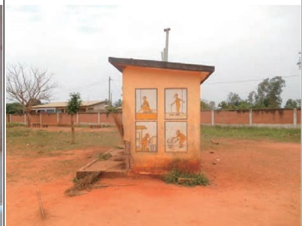
トイレ壁面（使用方法の絵が描かれている） ID 27 EPP KPOMASSE-CENTRE/A
