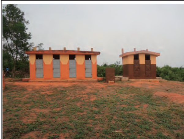
トイレ棟 ID 7 HOUNGO
