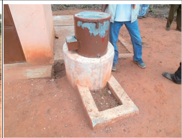
トイレの前に設置された手洗い用水タンク ID 35 EPP WINYIKPA-CENTRE
