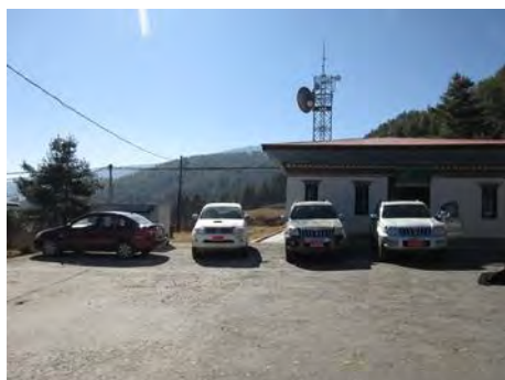
ジャカール電話局(事業実施サイト)機械棟
