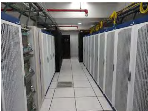
並列運転予定既存携帯電話コアシステム (交換機) (ティンプー)
