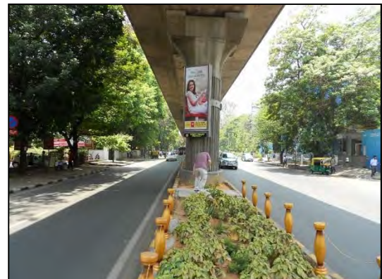
写真- 12 : MG Road エリア 可変表示板設置場所調査
