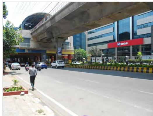
写真- 11 : MG Road エリア 可変表示板設置場所調査
