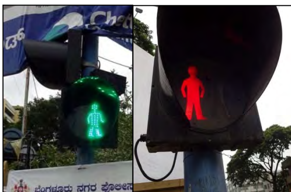
写真- 5 : 歩行者信号機 青色(LED タイプ)、赤色(電球式)
