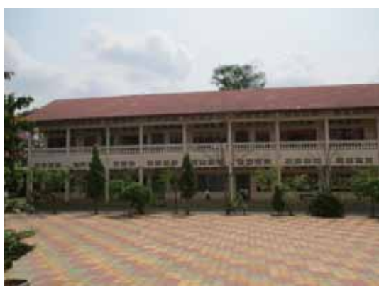
PTTC 既存教室棟-1 外観
