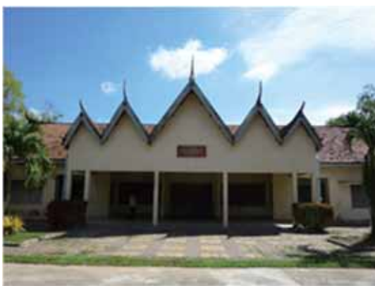
RTTC 集会室棟外観 施設全般に劣化がみられる 解体後建替の予定
