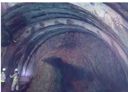
切羽状況 (南側) (平成 29 年 3 月)
