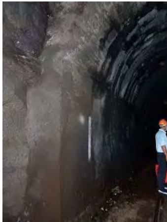
Vung Ro 4 トンネル補修箇所 (平成 29 年 7 月)
