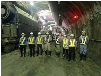
トンネル掘削現場視察 (中津3号トンネル) (平成 29 年 8 月)
