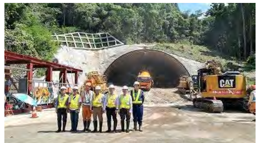
トンネル掘削現場視察 (下屋形トンネル) (平成 29 年 8 月)
