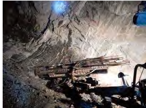
水路トンネル掘削現場 (平成 29 年 7 月)
