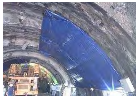
漏水対策 (南側) (平成 29 年 3 月)
