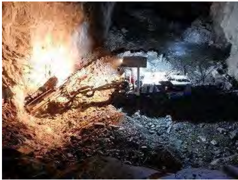
水路トンネル掘削現場 (平成 29 年 7 月)
