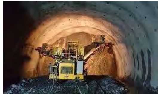
掘削状況 (北側) (平成 29 年 3 月)
