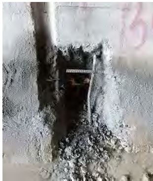
漏水対策（南側）（平成 29 年 3 月）
