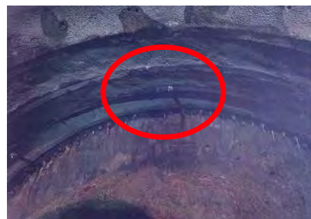
鋼管挿入状況 (南側) (平成 29 年 3 月)
