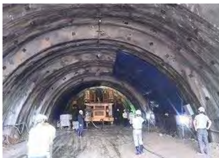
削孔状況 (南側) (平成 29 年 3 月)
