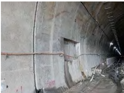
打継目（断面縦断方向）（平成 29 年 3 月）
