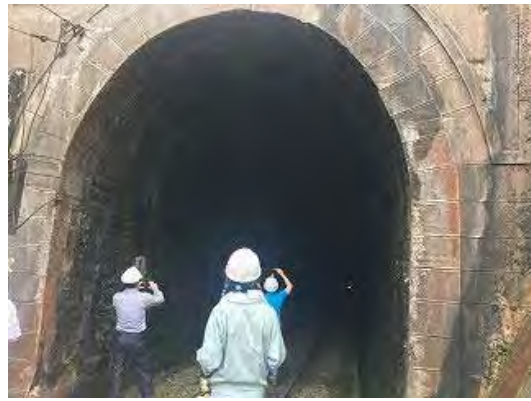
Banonneau 坑口部(平成 29 年 4 月)
