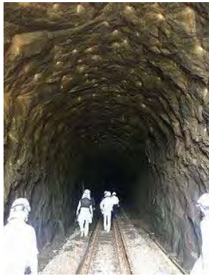
Vung Ro 4 坑内状況(平成 29 年 4 月)
