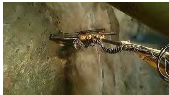
削孔状況 (北側) (平成 29 年 3 月)
