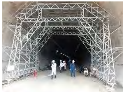
Ca Pass トンネル現地視察 (平成 29 年 3 月)
