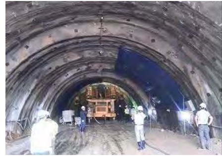
Cu Mong Pass トンネル現場視察 (平成 29 年 3 月)
