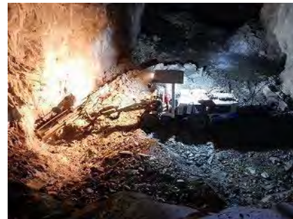
水路トンネル掘削現場 (平成 29 年 7 月)
