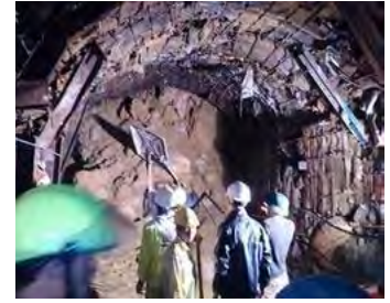
図-1 ラムドン省の崩落事故現場
