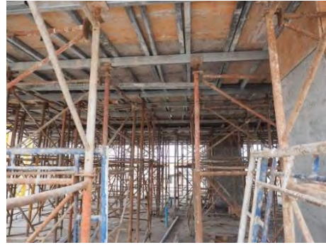
■ビエンチャン市内の建設現場② 4階床の支保工事状況。木材ではなく、鋼管(ビティ足場)が使われている。
