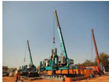
■既成RC杭の圧入機 既成杭の圧入工法は、現地で一般的な工法である。
