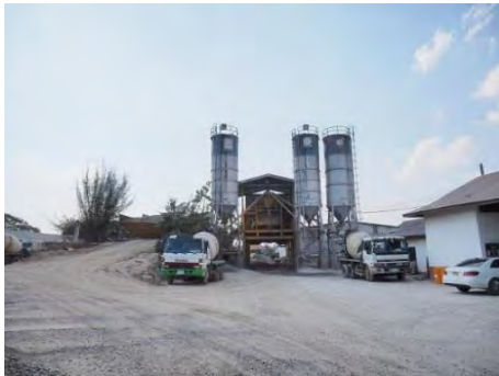
■生コンプラント ビエンチャン市内には生コンプラントが数箇所あり、建設工事で一般的に使用されている。
