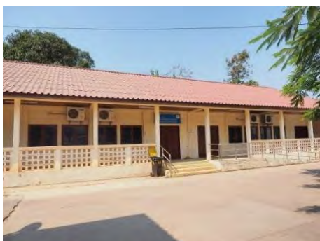
■クリニカルラーニングセンター（CLC）外観 4室の中に間仕切りがあり、8室として使える。建物の状態は良好。
