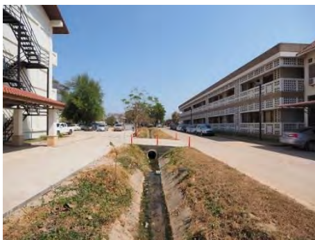
■建設予定敷地南側の水路 既存浄化槽からの処理水と雨水を放流している。全面に渡り蓋等はない。通路橋の幅員は 5m。
