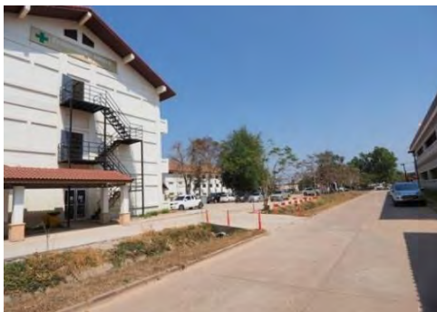
■建設予定敷地南側の敷地内通路 幅員 6mの敷地内通路。コンクリートにより舗装されている。病棟-2 への車輛アクセス路となっている。
