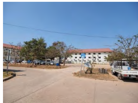
■建設予定敷地への通路橋 幅員 4mの水路に架かる橋。計画施設へのアプローチとして架け替えが必要である。
