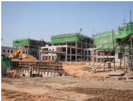
■ミタパープ病院増築工事現場 オーストリアの有償支援による延べ床面積約2万平米の病院。施工管理はしっかりしている印象。
