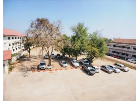
■建設予定敷地全景②：西側より望む 工事開始前に手前の駐車場の舗装、縁石、樹木の撤去が必要。
