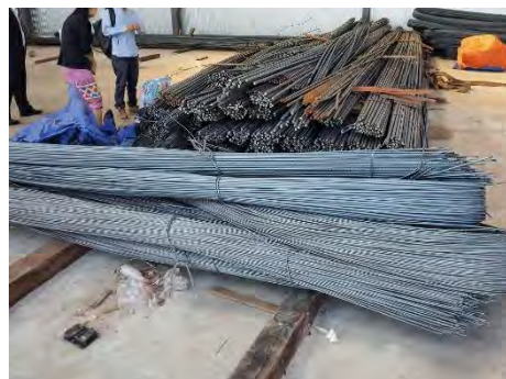
■鉄筋保管状況 屋根付きの保管場所で、鉄筋の下に枕を置いており保管状況は良好。
