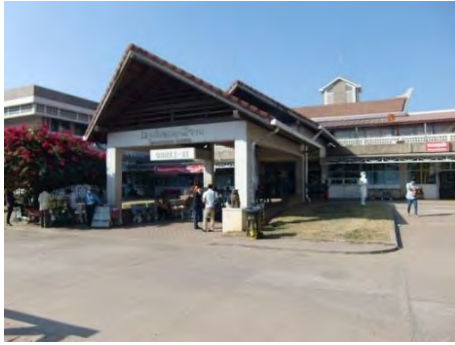
■セタティラート病院外観：施設自体の維持管理状況は良好。アプローチ下ベンチは患者を待つ家族等が利用。
