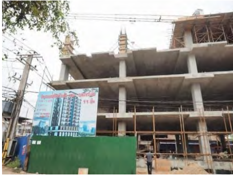
■ビエンチャン市内の建設現場① 11階+地下1階の共同住宅建設現場。建設会社はラオス企業だが、作業員はベトナム人が多い。
