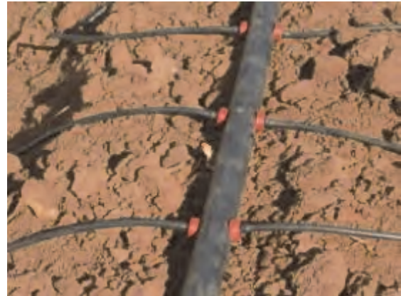
Sistema de irrigação por gotejamento com tubulação sem pressão
