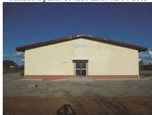
Depois da construção: Tomada a partir do lado Oeste: 02/07/2015
