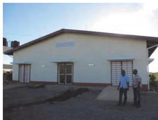
Depois da construção: Tomada a partir do lado Este: 02/07/2015
