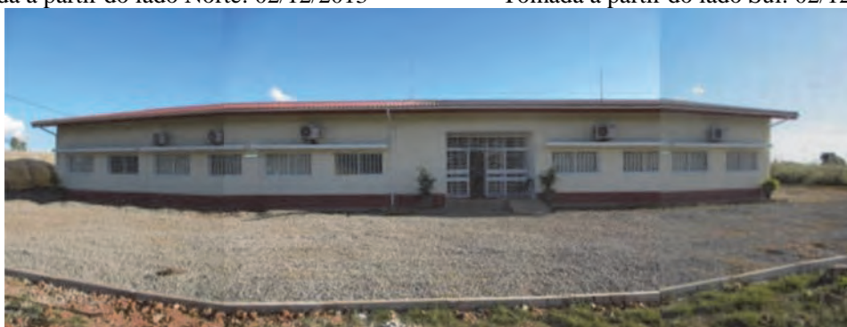
Depois da construção: Tomada a partir do lado Norte: 02/07/2015
