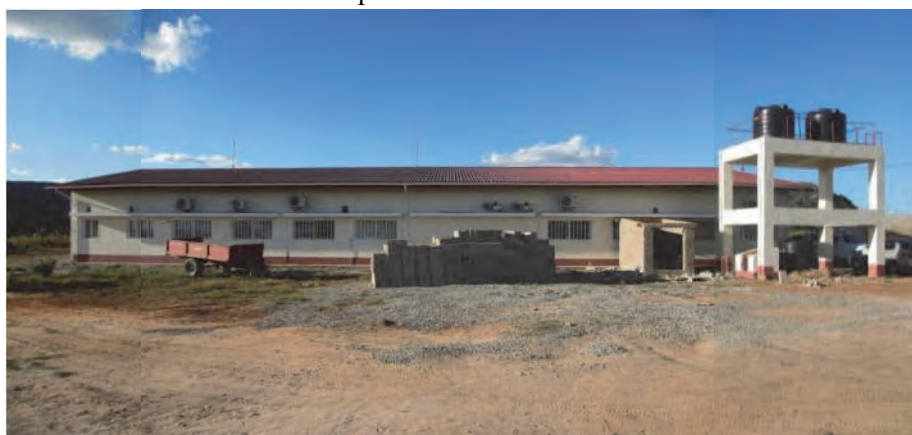
Depois da construção: Tomada a partir do lado Sul: 02/07/2015
