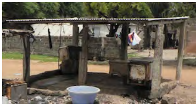
ポワントサレーン（施設建設前） コンクリート柱にトタン屋根 保冷魚箱と中古冷蔵庫を使用
