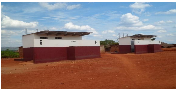
Figura 33 latrinas construídas nas escolas no âmbito do PROSUAS
