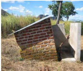
O poço da latrina desmoronado e a parede de vedação inclinada.
