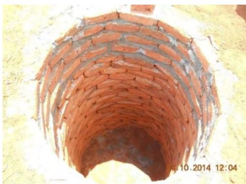
Obra de reforço da parede interior do poço da latrina
