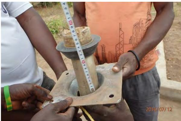
O tubo de elevação com corda e o ponto de amarra é determinado verificando-se as condições de içamento.
