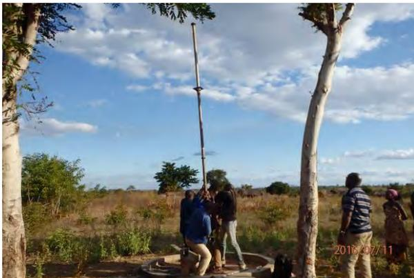
Tubo de elevação de PVC retirado devido ao total entupimento com areia.
