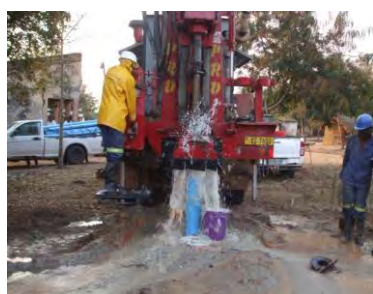
掘削中 (エアーパーカッション工法)
