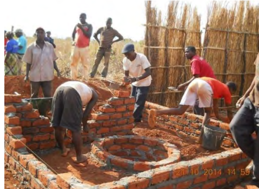
トイレ建屋の建設
