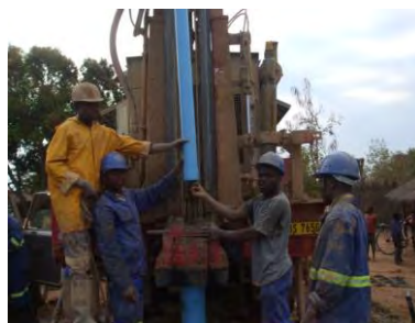
ケーシングパイプ挿入
