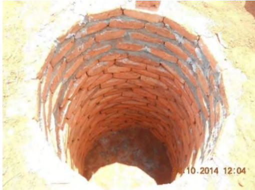
トイレの穴の内側の補強工事
