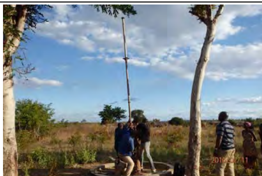
PVC 揚水管が砂で詰まっているため揚水管全てを抜き出した。
