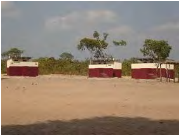
学校用トイレの全景 (2015年8月25日：マジユネ郡 Paundi 小学校)
