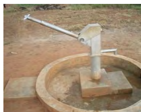
ポンプ設置状況
