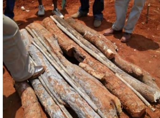
現地で入手可能な資材によるトイレ床
