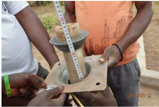
揚水管はロープで吊るが、吊り具合を確認しながらロープの縛る位置を決めている。
