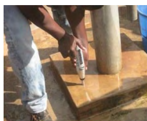
コンクリート強度確認
