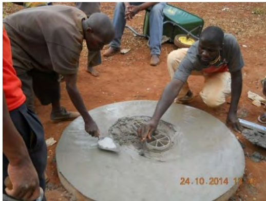
トイレスラブの作製
