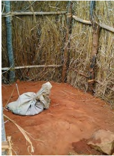
入手可能な資材によるトイレの蓋（袋に砂を詰め て凹凸のある地面の穴をふさぐ工夫）
