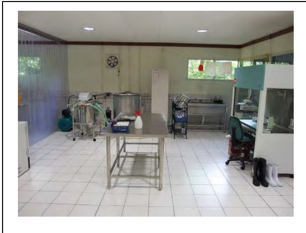
図 9g 室内写真 (図 8 エリア②) コメを洗米するための浄水設備と軟水器 (奥) 微生物検査・操作をするクリーンベンチ (右)
