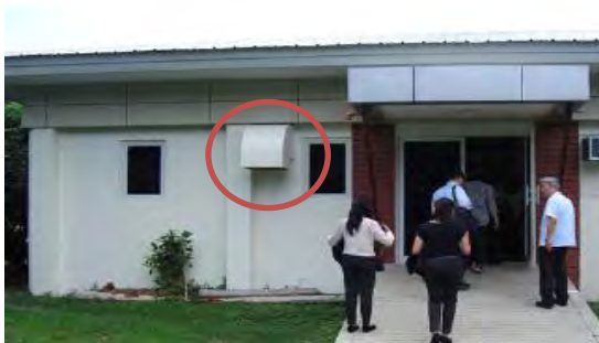
図 9c 設置場所外観写真 室内の衛生を考え、排気ファンを設置。
