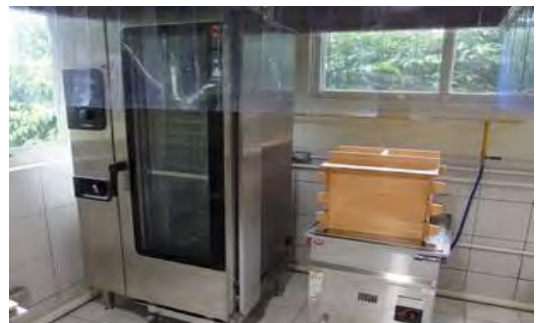
図 9f 室内写真 (図 8 エリア①) 炊飯のための蒸し器 (右) と殺菌の用の スチーム・コンベクション・オーブン (左)
