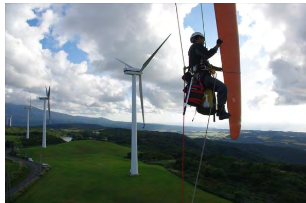
風力発電設備の点検
