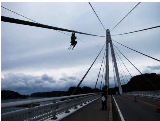
斜張橋ケーブルの点検
