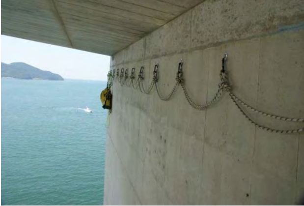
支点の設置例（コンクリート構造物） 出典：提案企業作成資料
