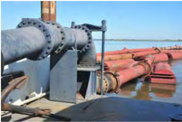
写真 2-5: 同じく Villeta 港に係留中の浚渫船 D-4 に連結されている水上排泥管。
