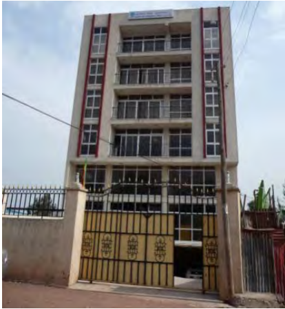
写真-1：EKI 本部 ビル外観 地下1階地上7階の鉄筋コンクリート造。前面道路と敷地は門扉で隔てられている。
