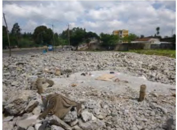
写真-8：建設予定地 既存倉庫撤去跡 コンクリートの床版、木造柱が部分的に残存している。
