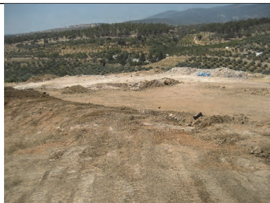
TP03 ジェラシュの新規中継基地建設予定地。UNDPにより中継基地施設が建設（2018年8月に竣工予定）され、その中に本プロジェクトにより屋内型圧縮装置が調達、据付される。
