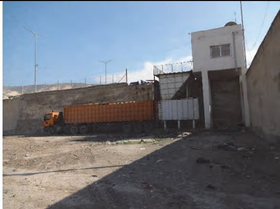
TS01. アグワ・シャミリヤ中継基地。新規圧縮装置を設置するためには、既存圧縮装置の向きを変える、擁壁構造の変更等、大規模な工事を伴う。
