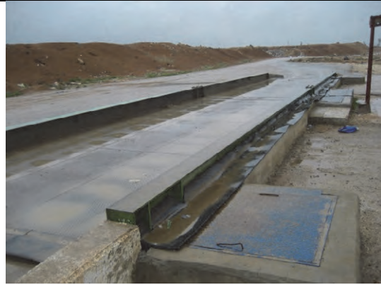
DS05. アル・フセイニャット最終処分場。ザータリのシリア難民キャンプのごみを受け入れる北部で2番目の処理面積を有する最終処分場。
