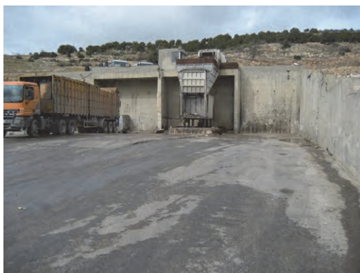
TS03. アジュール中継基地。既存圧縮装置の左側に新規圧縮装置の設置が可能。
