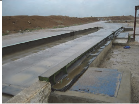
DS05. アル・フセイニヤット最終処分場。ザータリのシリア難民キャンプのごみを受け入れる北部で2番目の処理面積を有する最終処分場。
