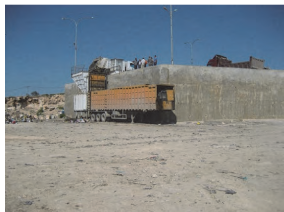
TS02. ラビエト・アルクーラ中継基地。既存圧縮装置の右側に新規圧縮装置の設置が可能。
