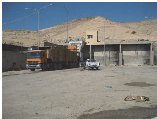
TS09 アル・ショネ・アル・ヴスタ中継基地。既存圧縮装置の右側に新規圧縮装置の設置が可能。
