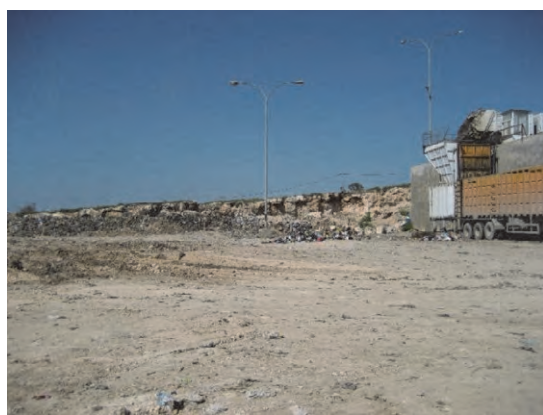
DS04. ラビエト・アルクーラ最終処分場。中継基地に隣接し、既に閉鎖されているべき最終処分場だが、中継基地の中継運搬能力不足のため継続使用。
