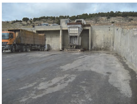
TS03. アジュルン中継基地。既存圧縮装置の左側に新規圧縮装置の設置が可能。
