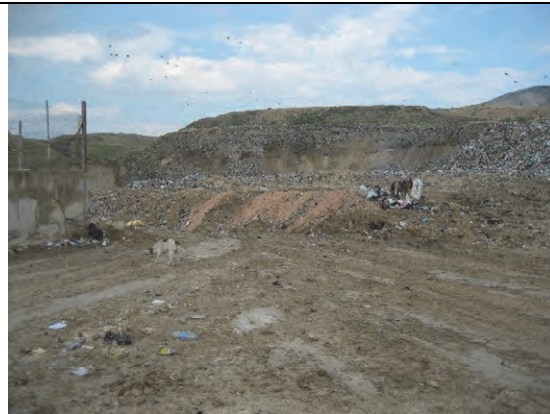
DS03. アグワ・シャミリヤ最終処分場。中継基地に隣接し、閉鎖を予定しているが、中継基地の中継運搬能力不足のため継続使用。
