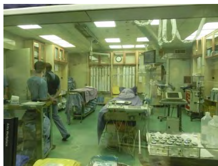
□血管X線撮影装置 シングルプレーン 機齢7～8年程度。1台しかなく、救急患者のカテーテル治療は他院へ紹介する。隣接する医師室及び倉庫を改修して新アンギオ室（シングルプレーン床走行）を準備する計画。
