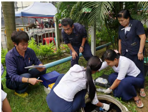
YCDC 職員による浄化槽の保守点検 (2017. 07. 27)
