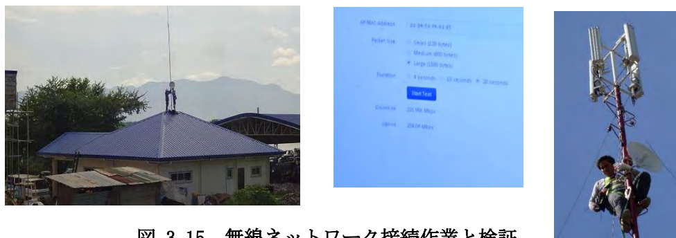
図 3.15 無線ネットワーク接続作業と検証
