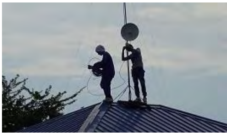
無線ネットワーク設置作業
