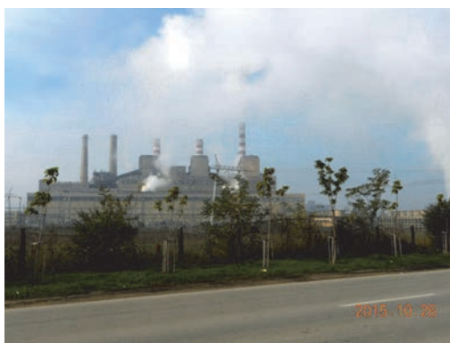
写真 8-1-5 Kosovo A 発電所全景 (左から A-1~A-5 号機)
