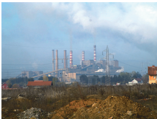
写真8-1-1 Kosovo A 発電所外観
