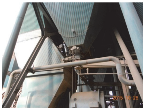
写真 8-1-4 ESP 出口ダスト濃度計
