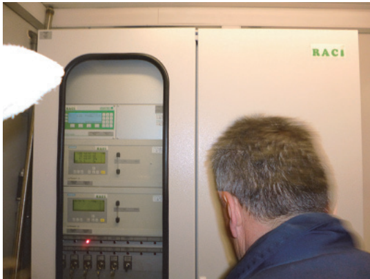
写真 8-2-3 排ガスモニタリング機器及びその設置場所
