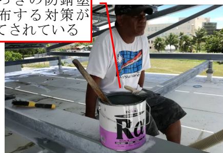
写真 3-4 防錆塗装の塗布
