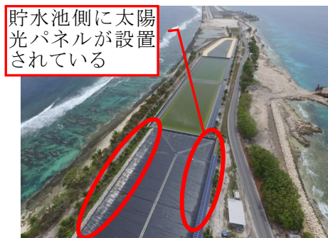
写真 3-7 貯水池側の太陽光発電施設
