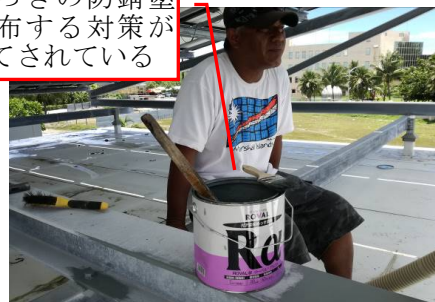
写真 3-4 防錆塗装の塗布
