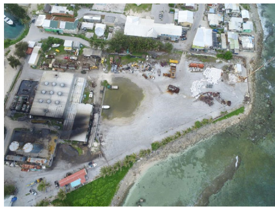
2: 写真左側が KAJUR の発電所 本プロジェクト用地に仮置きされている建機 などの撤去は KAJUR により実施予定
