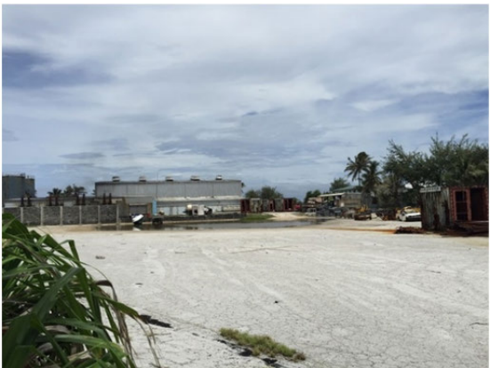
3: 本プロジェクト用地の状況 (用地東側から KAJUR 発電所を望む)
