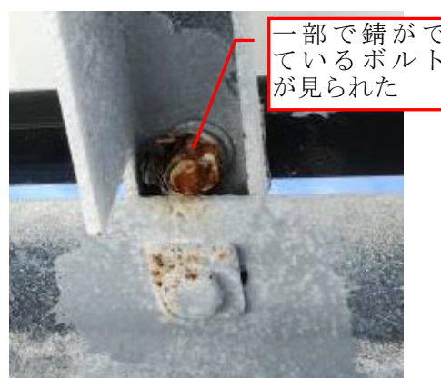
写真 3-2 架台ボルト部分
