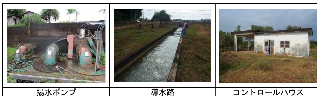
写真 2-10：揚水機場の現況
