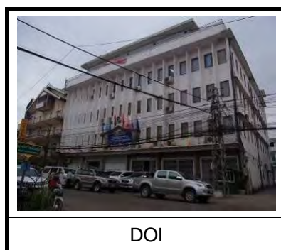
写真 2-1：実施機関庁舎
