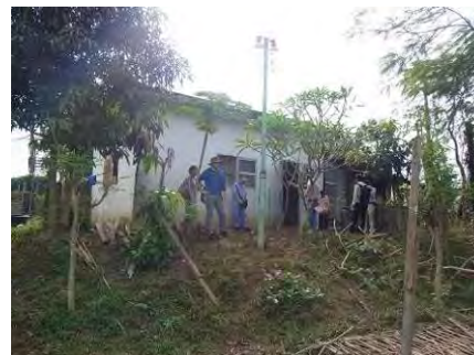
排水機場・コントロールハウス
