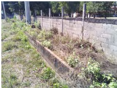
サブ・ラテラル用水路（No.6 分水工地点）
