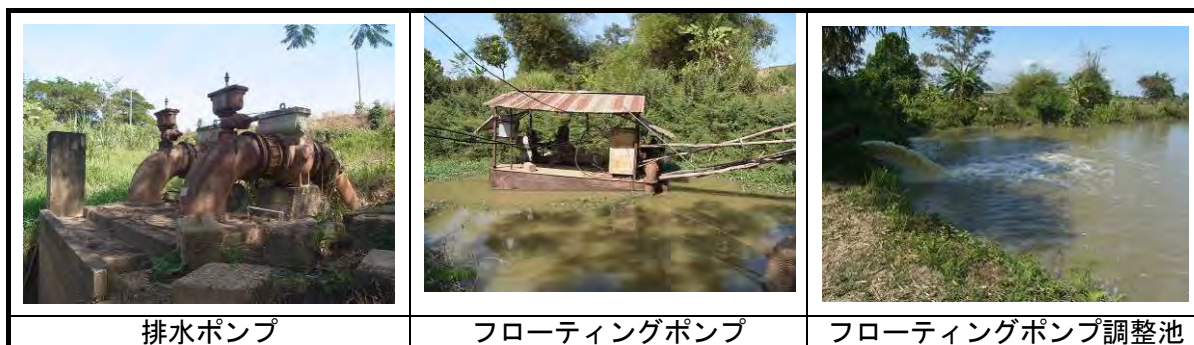
写真 2-11：排水機場の現況
