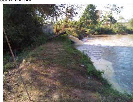
フローティングポンプ調整池
