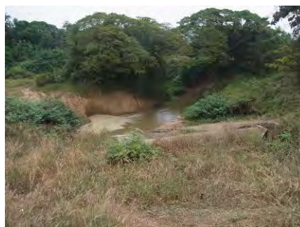
排水機場の放流先
