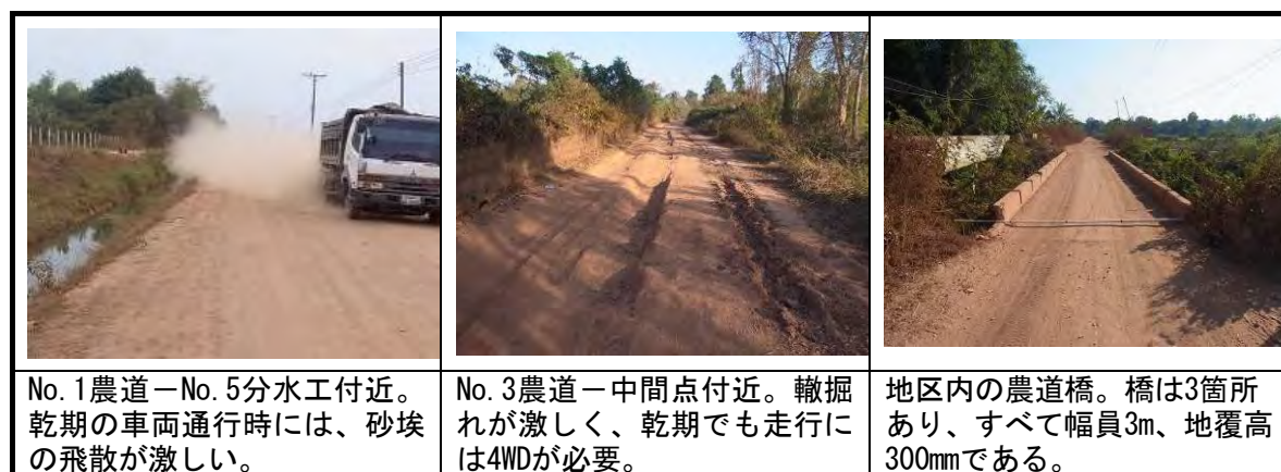
写真 2-15：幹線農道の状況
