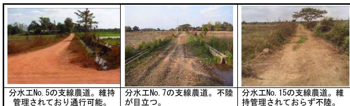
写真 2-16：支線農道の状況
