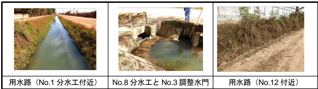
写真 2-12 : 北幹線用水路現況
