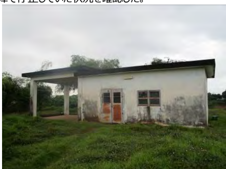
揚水機場・コントロールハウス
