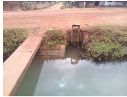
分水工（No.1 分水工地点）
