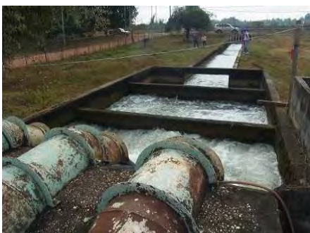
揚水機場・導水路
