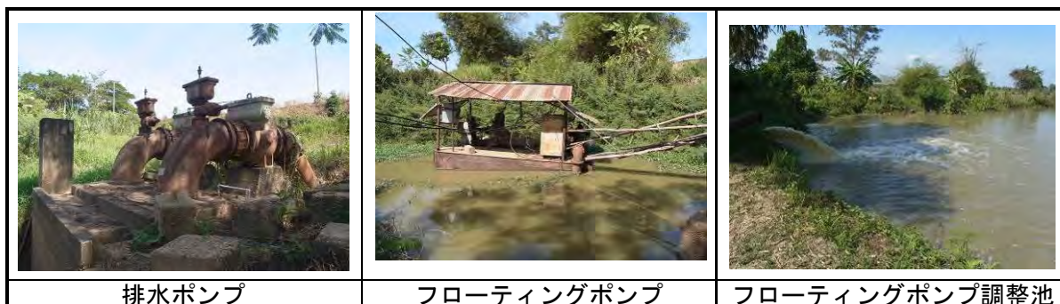
写真 2-11：排水機場の現況
