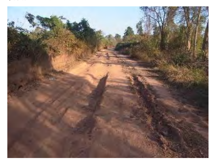
農道の状況 (No3 農道)
