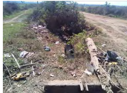
ラテラル用水路（No.10 分水工地点：起点）
