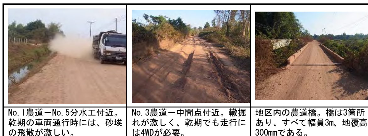
写真 2-15：幹線農道の状況
