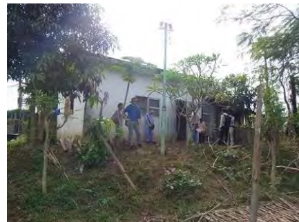
排水機場・コントロールハウス
