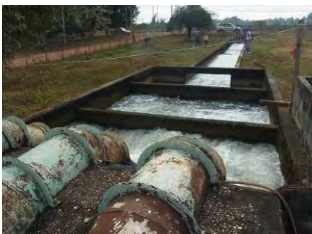
揚水機場・導水路
