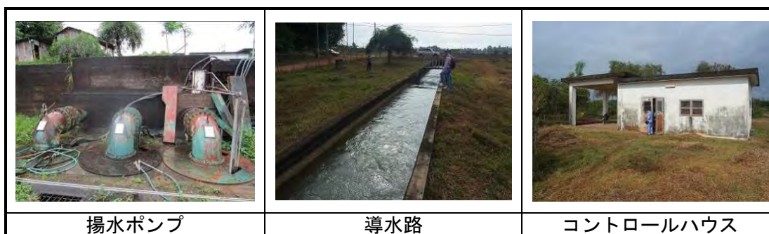
写真 2-10：揚水機場の現況
