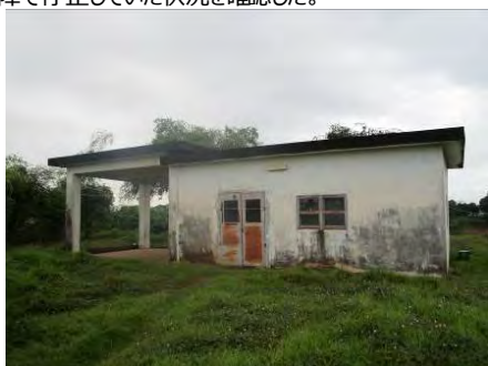
揚水機場・コントロールハウス
