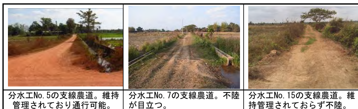
写真 2-16：支線農道の状況
