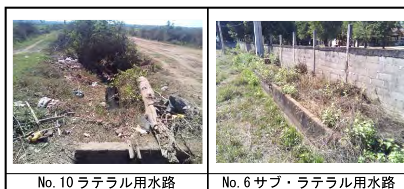
写真 2-13：ラテラル用水路、サブ・ラテラル用水路現況
