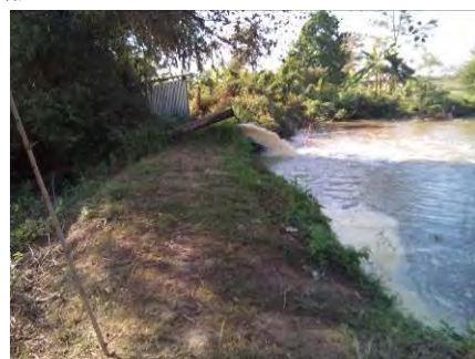
フローティングポンプ調整池
