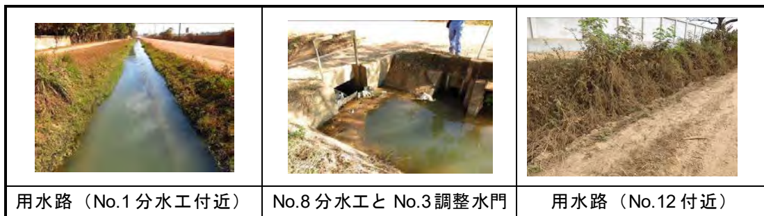
写真 2-12 : 北幹線用水路現況
