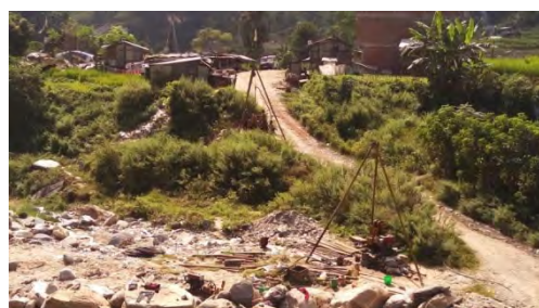
写真 2 地質調査の現場
