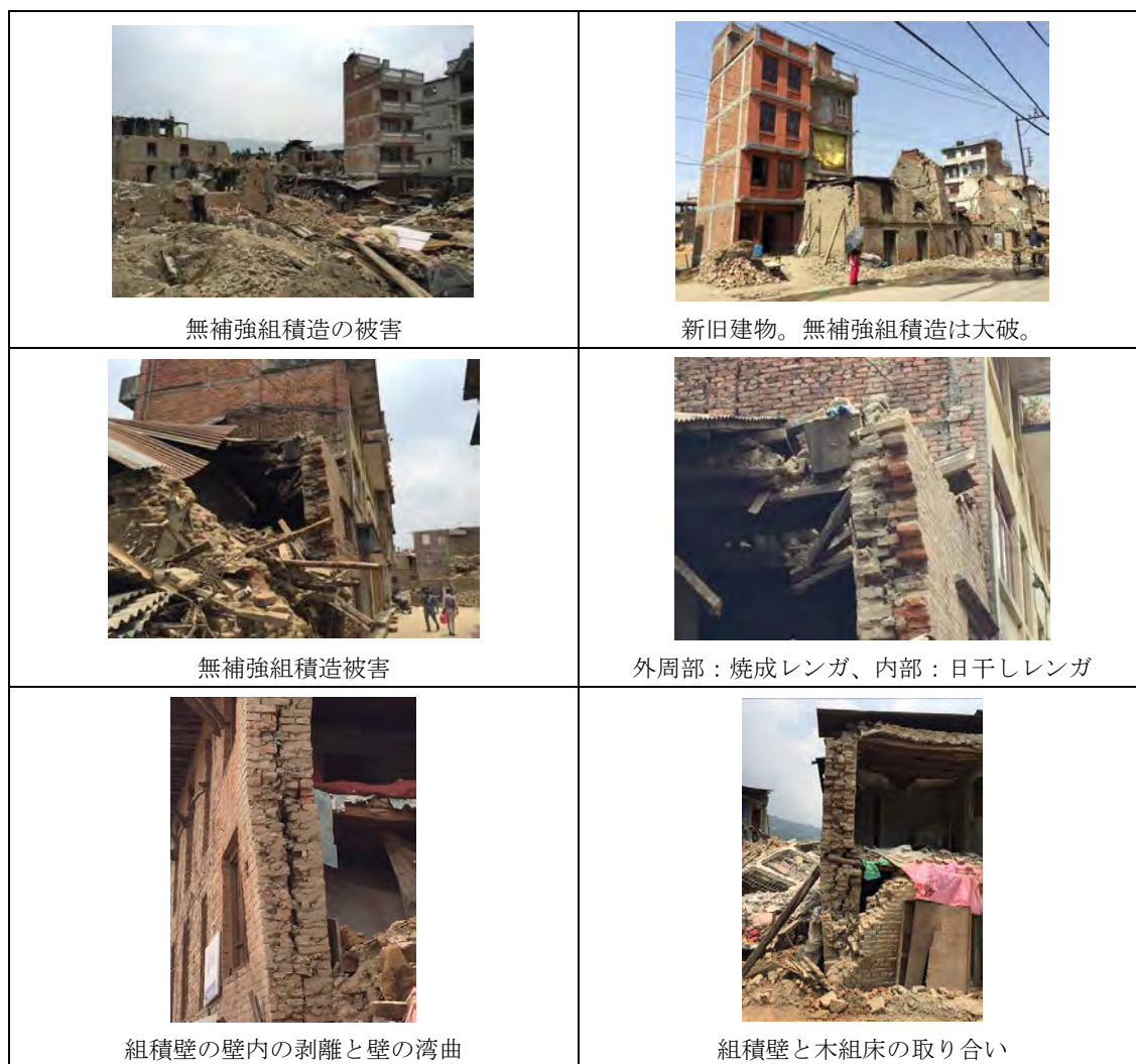
図 8.2.2 カトマンズ盆地および近郊の住宅被害事例
