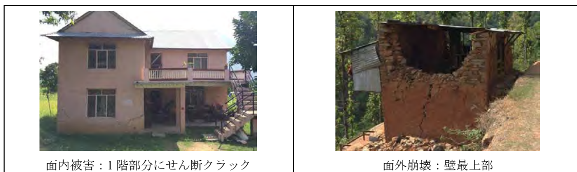
図 8.2.3 1階部分面内被害と2階部分面外被害
