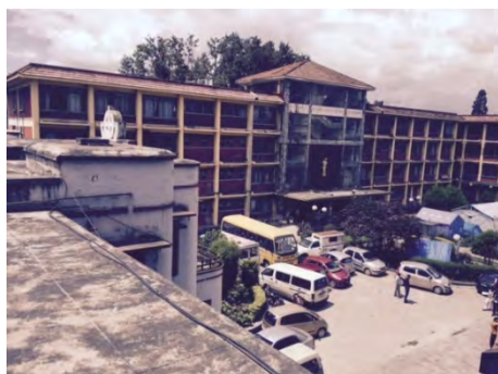
パロパカール産婦人科病院（メイン棟）
