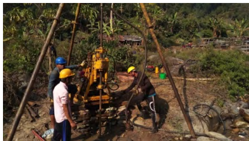
写真 1 地質調査の現場
