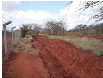
洪水が激しいので大きく掘った明渠
