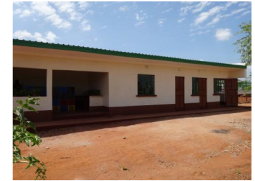
作業室: 倉庫: 事務室: 警備員詰所
