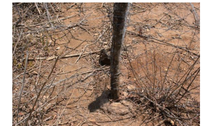
① 木の杭に根元はコンクリートで固めている
