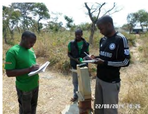
MIS データベースへ入力するために 井戸情報を収集する郡職員 (2014 年 8 月 22 日：ムウェンセ郡)
