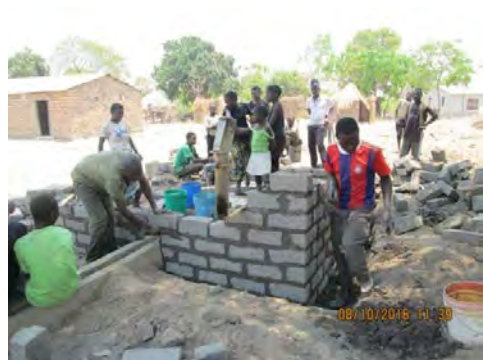
ハンドポンプの周りにフェンスを設置する地域住民 (2016年10月8日 ミレンゲ)
