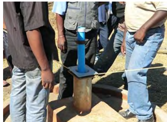
PVC 製揚水管への交換 (Afridev 型ハンドポンプ)
