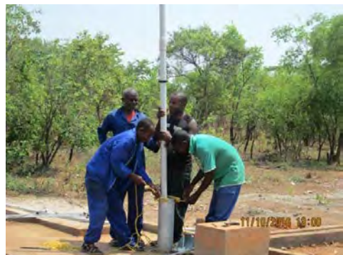
新設井戸でのポンプ修理工によるハンドポンプ据付作業 (2016年10月11日 ムウエンセ)
