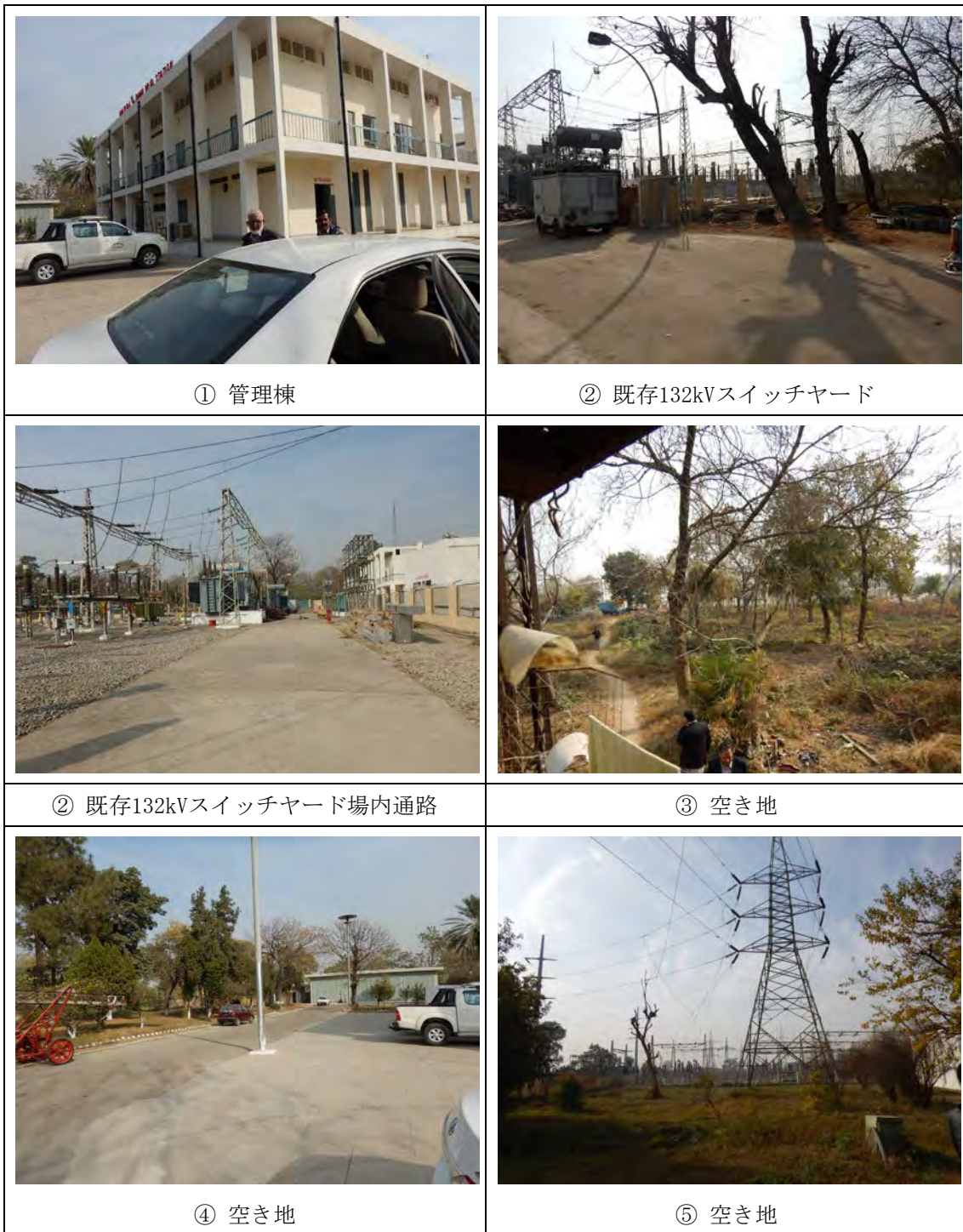
写真 9.1.1 現地写真（ゼロポイント変電所）
