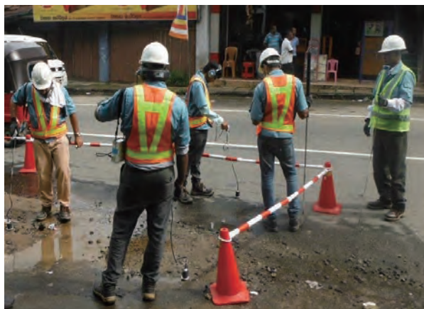
漏水位置特定作業 (2016/6/3)
