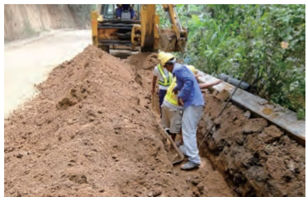
配管周りの処理・締め固
