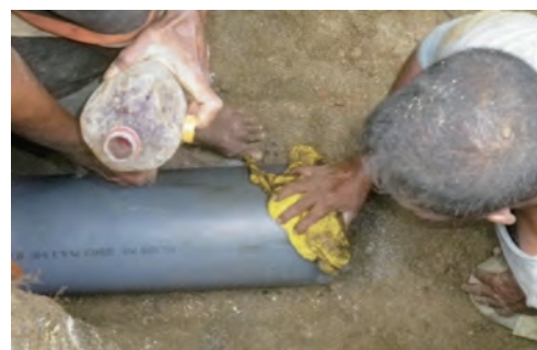
配管作業時の継ぎ手部分の清掃
