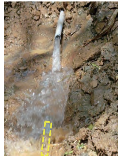
写真 9: 不断水の工事
