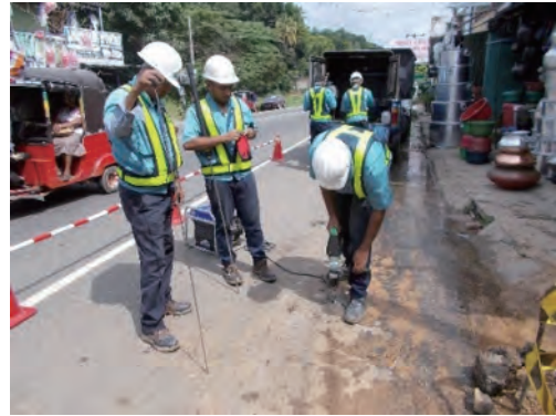
ボーリング作業風景
