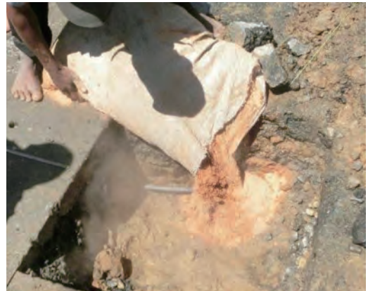
写真13: 良質土による埋戻し
