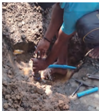
写真 5: 地表近くの分岐工事
