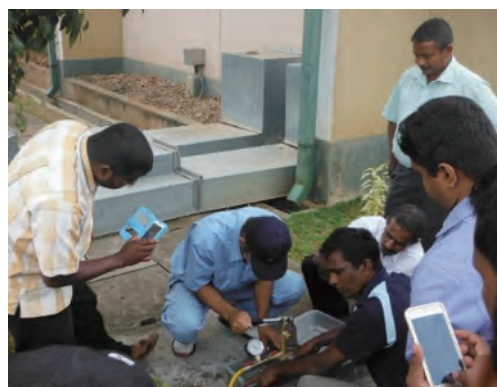
テストポンプによる水圧測定
