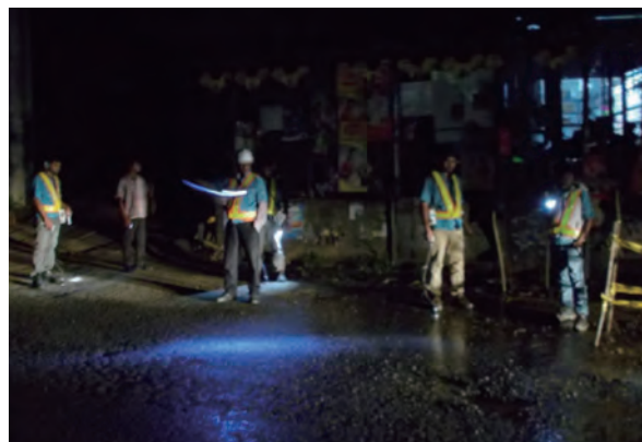
夜間の路面調査
