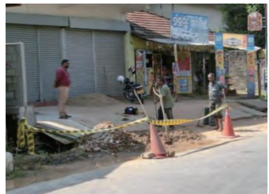
写真14: 安全帯の設置状況
