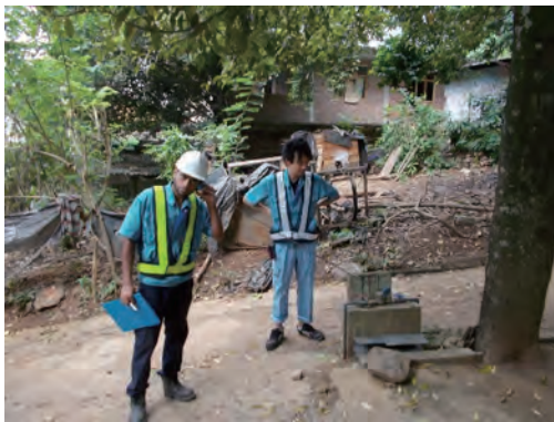
音聴棒による漏水音チェック
