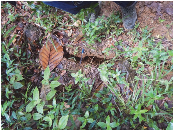
写真 3-25 滑落崖付近に見られる亀裂
