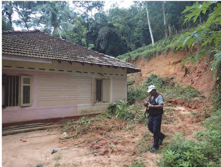
写真 3-27 切土して宅地造成した斜面が崩壊した事例
