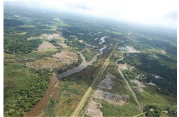
写真3-12 ギン川下流部の立派な築堤
