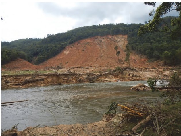
写真 3-23 表層崩壊の事例 (Kosgulana)
