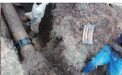
漏水修繕工事（石綿管） 接続部から漏水していた。
