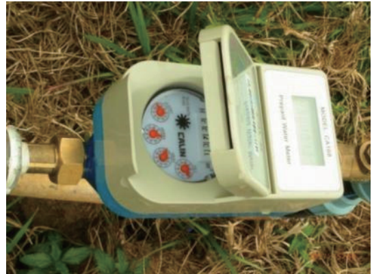
写真-3.12-9 プリペイド・メーター設置状況
