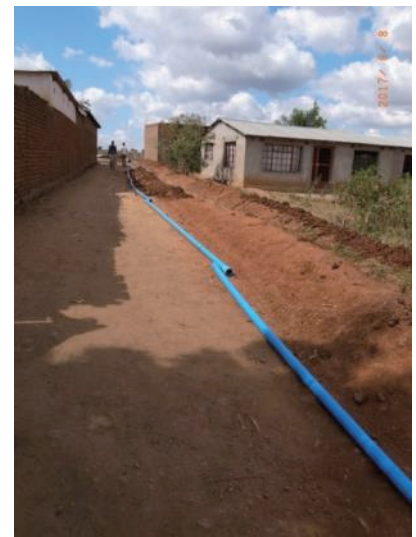
写真-3.12-13 給水管接続状況
