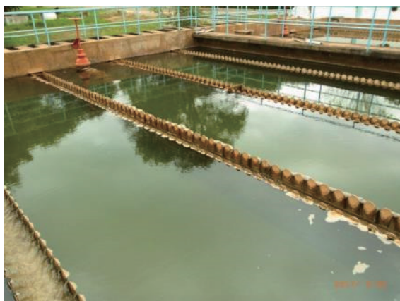
写真-3.10-1 TW I 沈殿池
