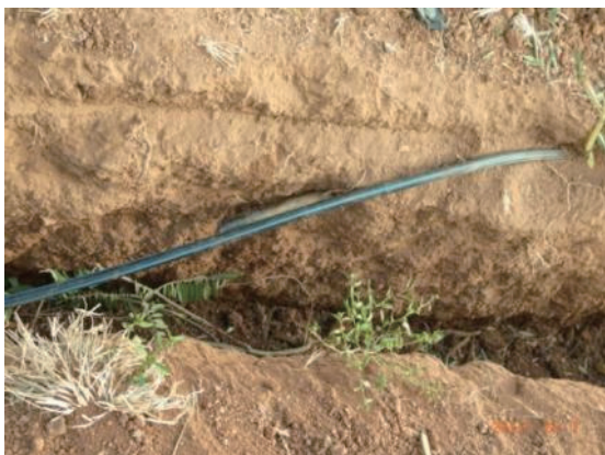
写真-3.12-10 浅く埋設（地表より 20cm 程度）されている給水管
