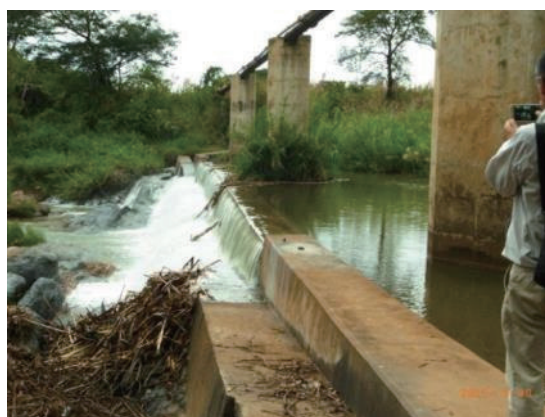
写真-3.1-2 下流の固定堰 (TW I 下流)
