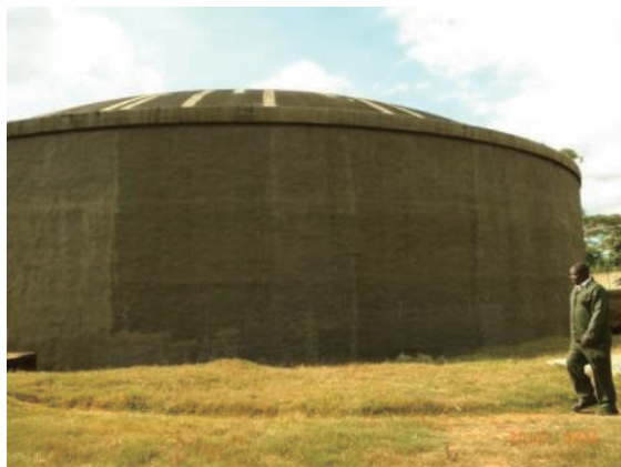
写真-3.1-3 配水池の状況
