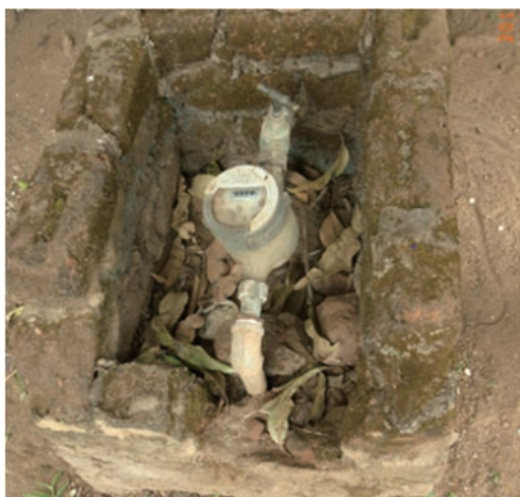
写真-3.12-2 メーター設置状況
