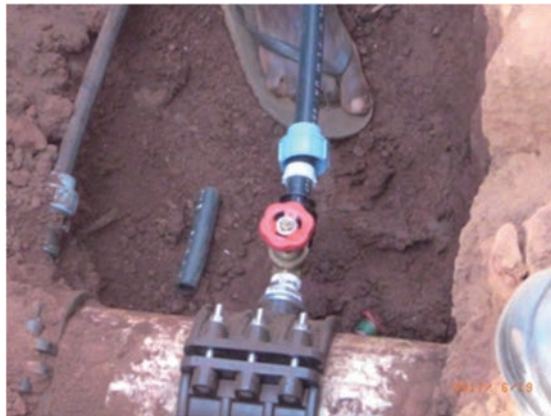
写真-3.12-12 給水枝管布設工事
