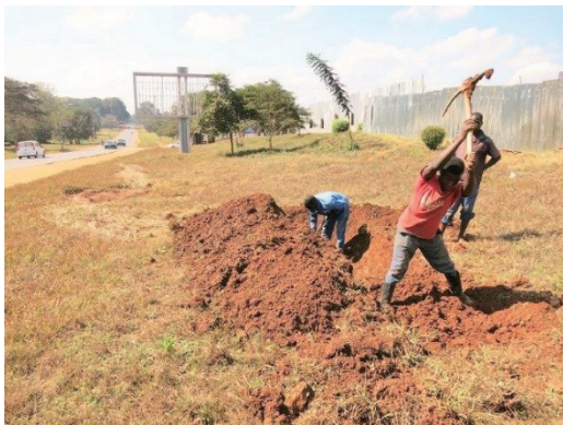
配水管の漏水箇所を特定するために人力掘削を行う。
