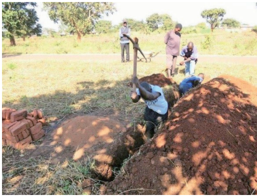
給水管新設工事現場にて人力で掘削を行う。
