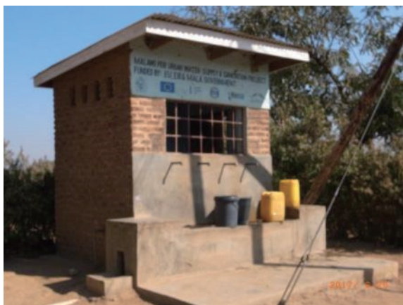
写真-3.1-8 Kiosk②の状況
