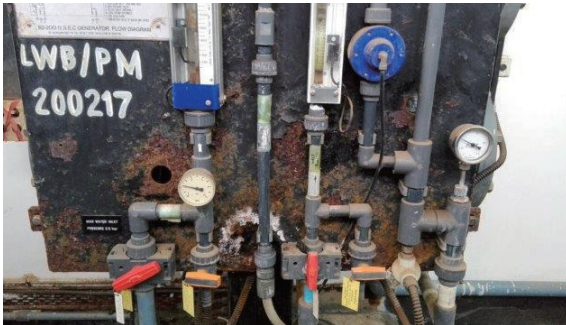
次亜塩素酸生成装置。1989年に設置され老朽化している。原料塩は英国から輸入している。
