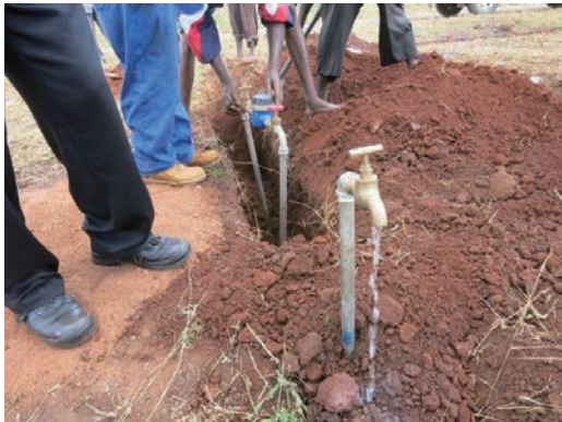
新設された給水管と水道メーター。
