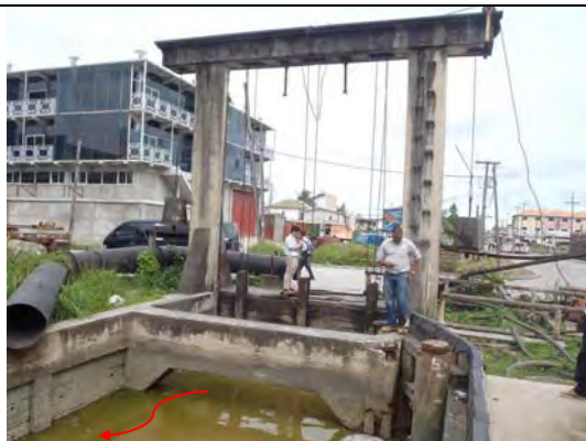
Princess St.水門
