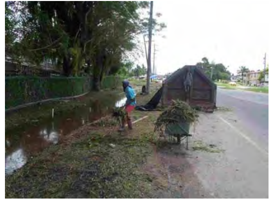
写真 R 2.2.1 排水路内草刈りの様子
