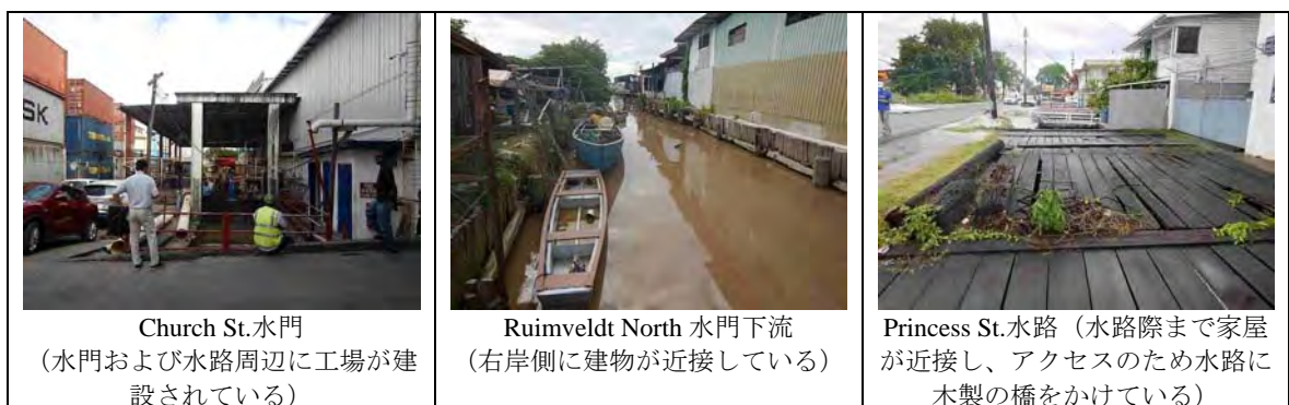
写真 R 2.1.2 既存排水施設付近に建設された施設・家屋
