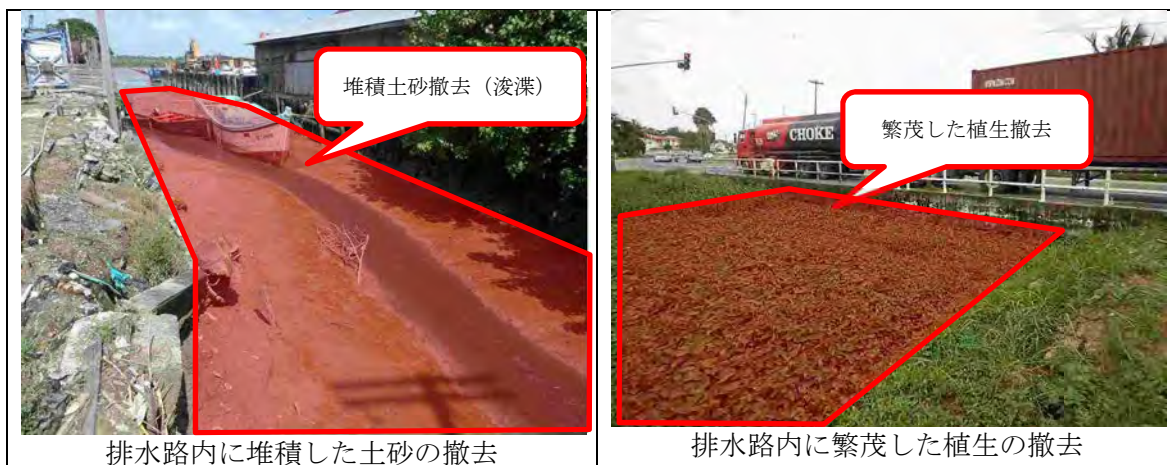
図 R 3.1.3 排水路内の土砂堆積や植生繁茂の撤去
