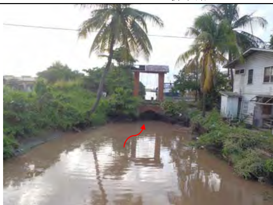
Ruimveldt South 排水路
