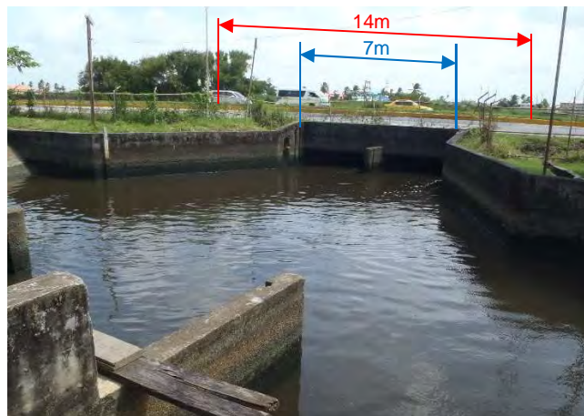
図 R 3.1.2 Liliendaal ポンプ場調整池流入部の拡幅
