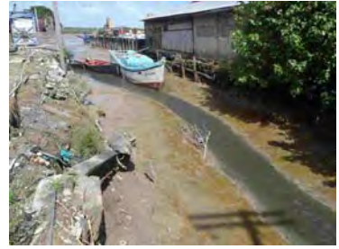
Sussex St. 水門下流の水路
