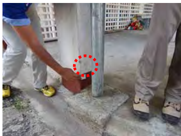
GT1（Court of Appeal Building の柱に設置）
