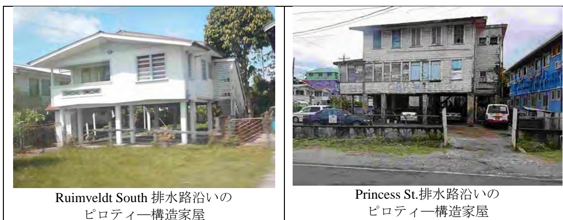
写真 R 3.1.1 ジョージタウン市内のピロティー構造家屋
