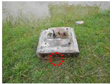
GT13 (旧電気通信施設基礎に設置)
