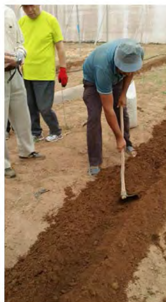
(Ouvrir la tranchée)
