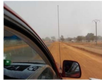
Photo: 3) Remblai en latérites de la couche d'assise de la RN3 et site d'extraction envisagé de part et d'autre de la route
