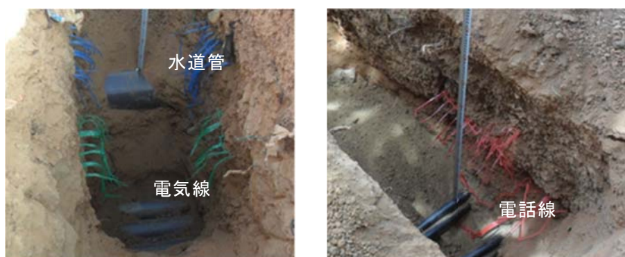
図 2.42 公共事業施設の埋設シート (水道管 (青) 及び電話線 (緑)、電気線 (赤))
