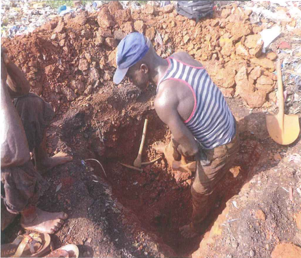
Site A8 Enta Marché Well P01 ; Depth : 1,50 m ; Surface :1 m 2
