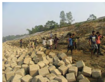
写真 3.5.: 土のうの撤去作業: 河川水位 5.42 m (PWD)、(2016年12月24日)
