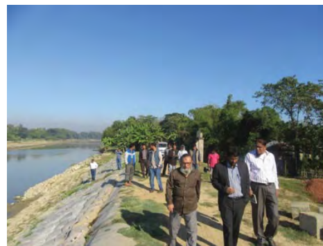
写真 3.3.: 施工業者、BDWB、専門家チームによる合同現場確認(2016年12月11日)
