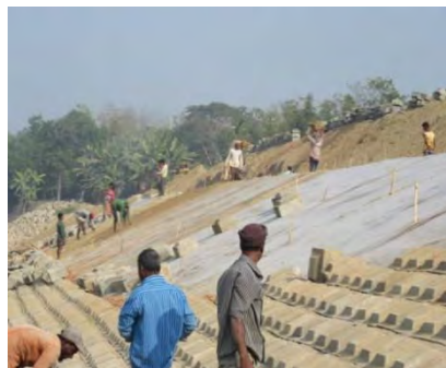
写真 3.8：法面保護工敷設状況（2017年2月2日）
