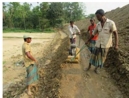
写真 3.10 : 川裏側築堤状況 (2017年4月15日)
