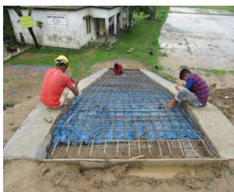
写真 3.11 : 階段工施工状況 (2017年4月22日)
