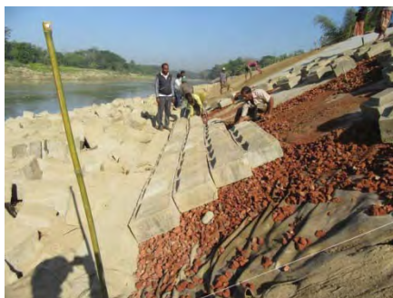
写真 3.7：法面保護工敷設状況（2017年1月26日）
