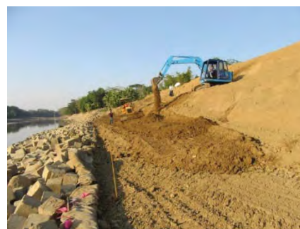
写真 3.6.: 重機による築堤状況 (2017年1月19日)
