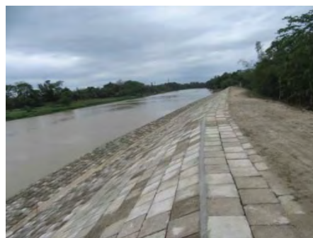
写真 3.9：法面保護工竣工状況（2017年3月30日）
