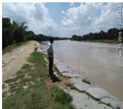
写真 3.2.: 工事中断中の洪水河川水位11.00m（PWD: 工事区間下流より上流を臨む）2016年9月15日。
