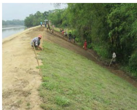
写真 3.12 : 川裏側張芝工施工状況 (2017年5月13日)
