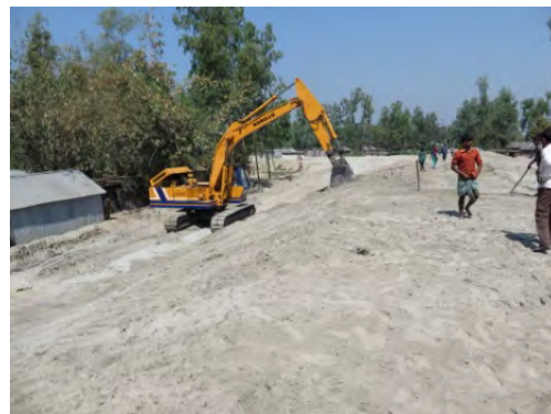
Bogra 地区における引堤工事（CCブロックによる法面保護工なし）
