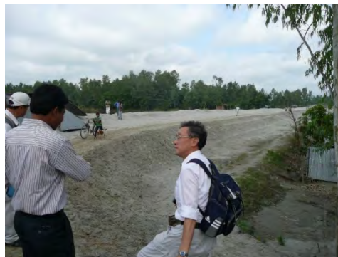
ジャムナ川 Bogra 地先の復旧堤防（建設中）
