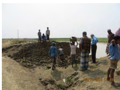
Haor, Netrakona 潜水堤防の補修工事
