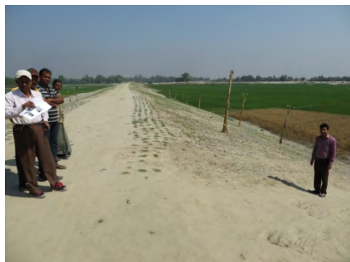
Bogra 地区における引堤工事（CCブロックによる法面保護工なし）
