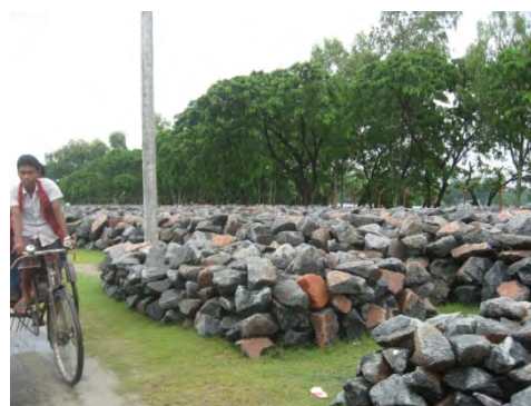
世界銀行資金による、Sirajganj Hard Point 根固め補修用集積石材
