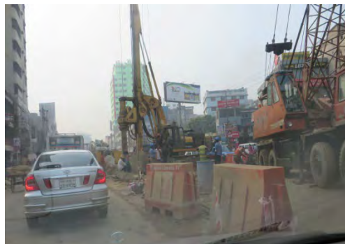
ダッカ市内、立体交差工事
