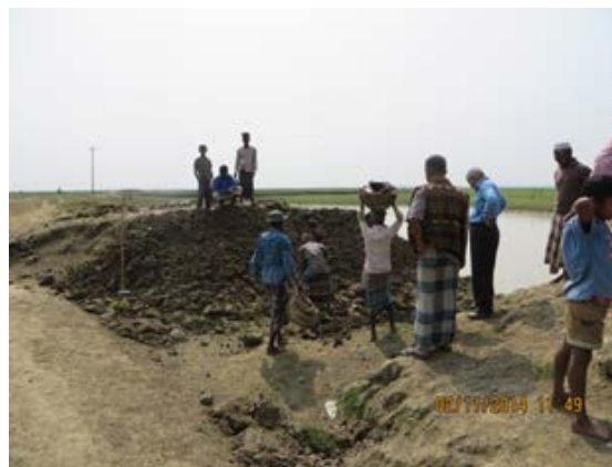
写真 2：修復工事中の堤防（Netrokona）
