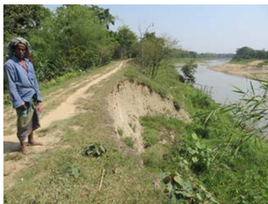
写真 3 : Moulvibazar の被災堤防
