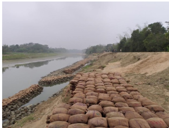
写真 4: パイロット工事 (2016 年 1 月 23 日)
