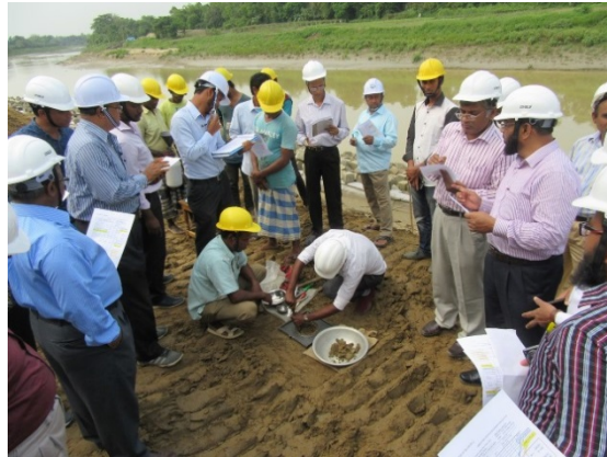
写真 5: 現場密度試験の実演（2016 年 4 月 2 日）
